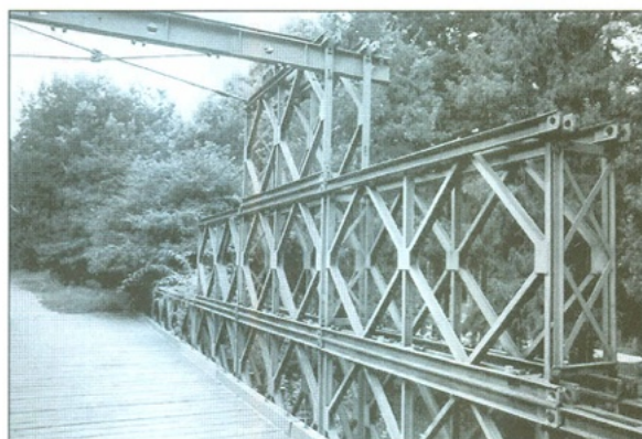
De 2 – 3 brug in het Liberty Park, Overloon.
